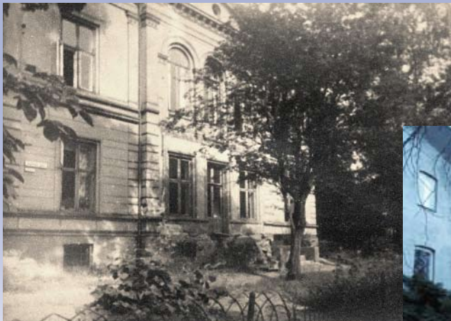
Fasaden mot Gustavs gate. Hagtornen var stor allerede dengang.
